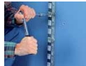
Die serienmäßige Wandhalterung ist mit Hilfe der Bohrersablonne schnell und sicher angebracht.
